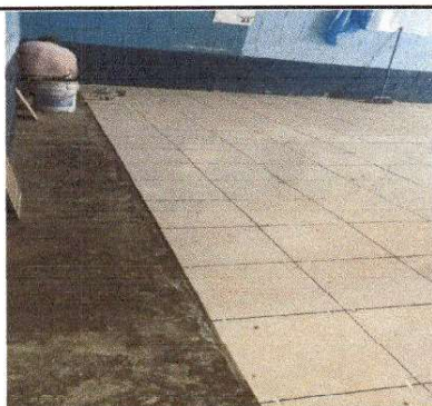
FOTO 3: PEGADO DE PISO CERAMICO SOBRE PISO CEMENTO
