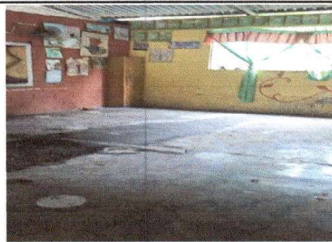
FOTO 6: REPARACION DE PISO AGRIETADO
