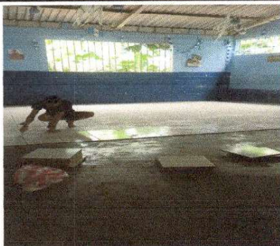
FOTO 1: PEGADO DE PISO CERAMICO SOBRE PISO CEMENTO
